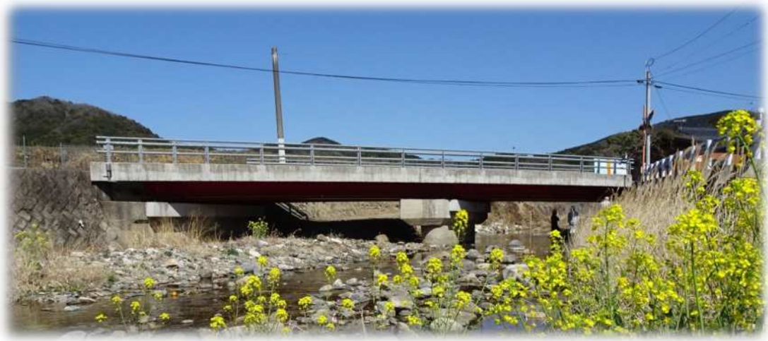
「馬渡橋 1972 年架設」
